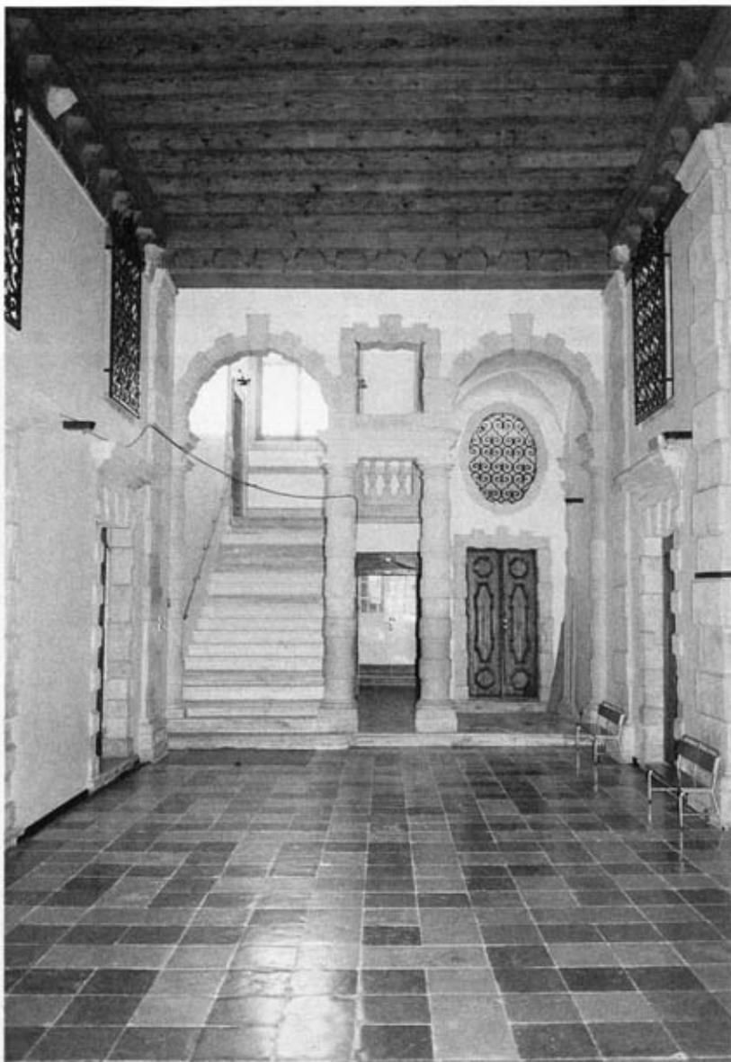
Foto n. 11, 12: due immagini dell'androne ad intervento ultimato, dopo la soluzione dei problemi tecnici sopra ricordati relativi ai giunti diversificati tra le formelle, all'andamento a dorso di mulo del piano di pavimentazione, alle quote diverse di ogni soglia, alla conservazione delle finiture superficiali autentiche.
